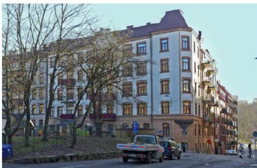
Figur 4. Fasaden mot Kastellgatan. Foto Antiquum AB.
