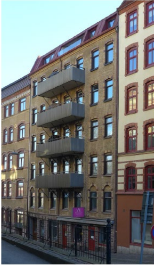
Figur 7. Fasad mot Kastellgatan. Foto Antiquum AB.
