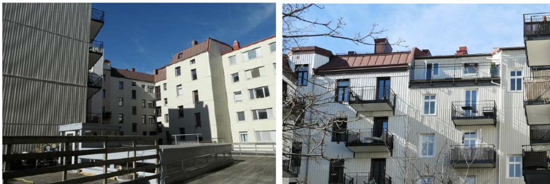
Figur 13. Till vänster: Gårdsfasad Skanstorget 10 uppförd 1898. fasaden är tilläggsisolerad och klädd med plåt. Foto Antiquum. Till höger: Gårdsfasad på Kastellgatan 6, uppförd 1930. Fasaderna är tilläggsisolerade, mot gården har det tillkommit en takterrass. Foto Antiquum
